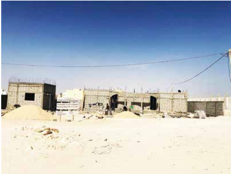
Avancée de la construction du Centre de Protection et d'Insertion Sociale des Enfants (CPISE - de Nouadhibou)
